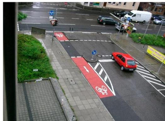
Abb. 4-36: Prinzipskizze und Beispiel (Stuttgart) zur baulichen Ausgestaltung einer Einfahrt
