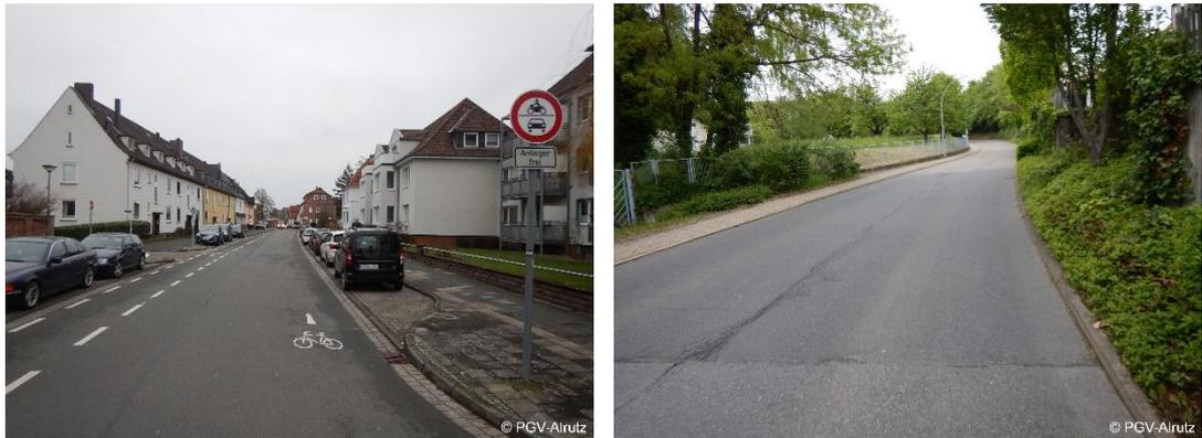
Abb. 4-30: Links: Beispiel für gemeinsamen Einsatz eines Schutzstreifens und einer gegenüber liegenden Piktogramm-kette auf der Fahrbahn (Celle, Niedersachsen); rechts: Beispiel zur Anwendung in Mosbach (Steige, Diedesheim)
