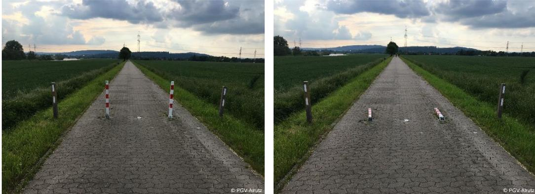
Abb. 4-37: Umklappbare Poller in hoch- und runtergeklapptem Zustand (Weserradweg, bei Hameln)
