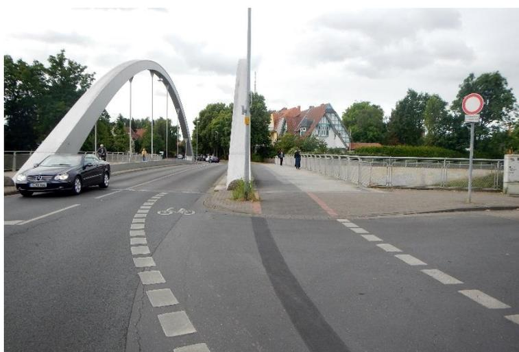
Abb. 4-9: Überleitung auf Fahrbahn (duale Führung) oder den nicht benutzungspflichtigen baulichen Radweg (Hannover)
