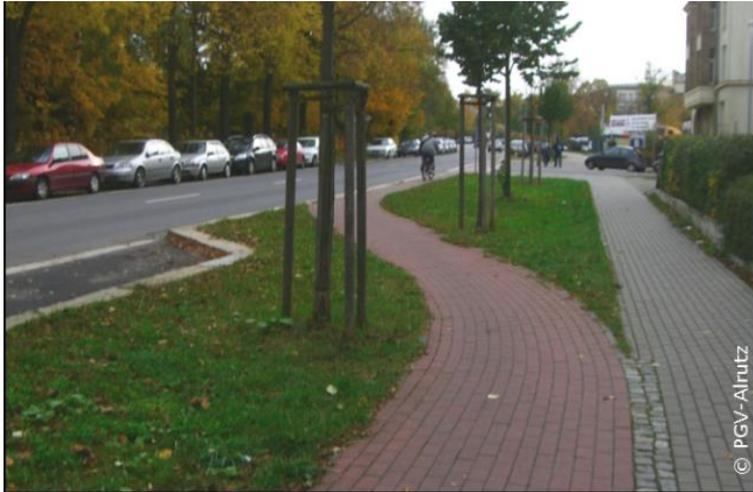
Abb. 4-15: Radverkehr wird im Vorfeld des Knotens an den Fahrbahnrand und damit ins Sichtfeld des Kfz-Verkehrs geführt
