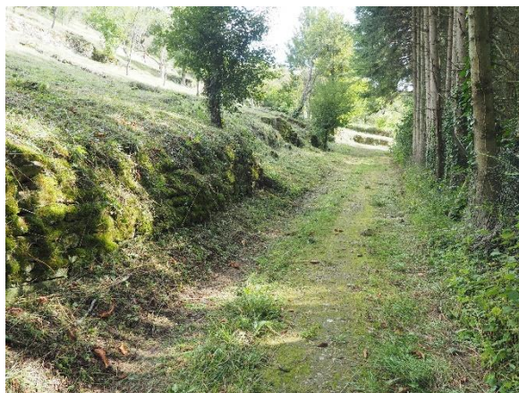
Abbildung 15: Durch Fichten beschattete und dadurch bemooste Trockenmauer im unteren Hangbereich der Mittelklinge
