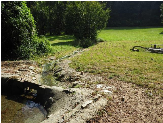
Abbildung 45: verbauter Wolfsgraben unterhalb der gefassten Quelle, bevor er verdolt ist
