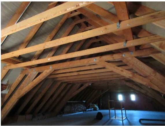
Foto 7: Mühle, Blick in den Dachstuhl
