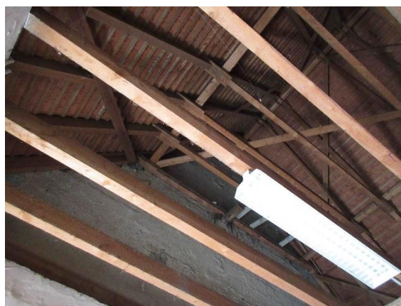
Foto 4: Dachstuhl der Scheune
