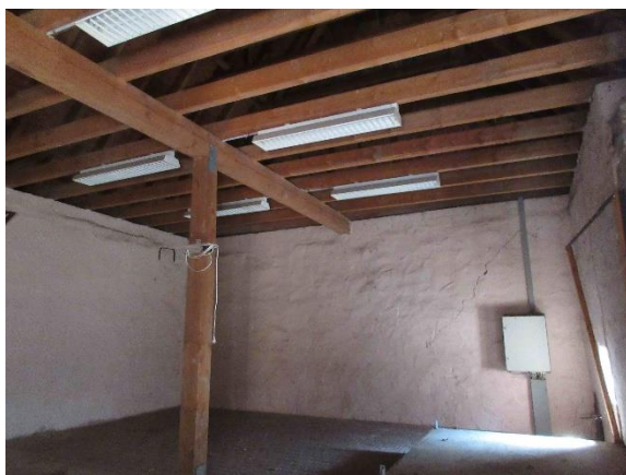
Foto 3: Blick in die Scheune
